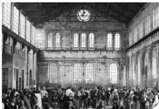
Fig. 3. Interno delle Officine Grandi
