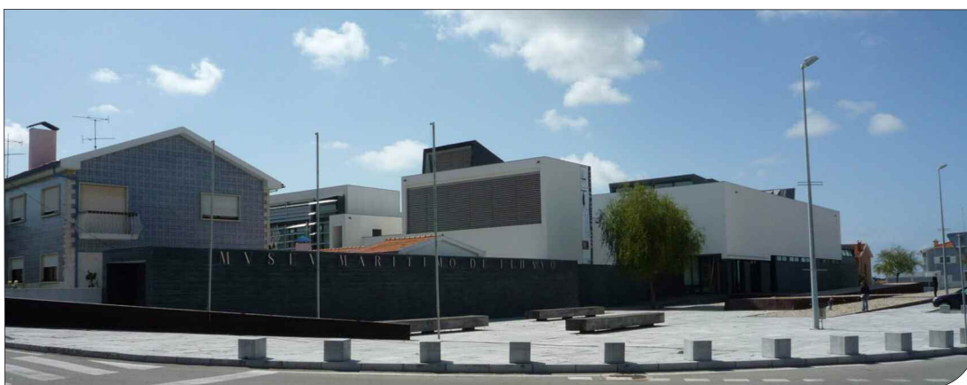
Fig. 1. L'edificio del Museu Marítimo de Ílhavo (foto G. Pinna).
