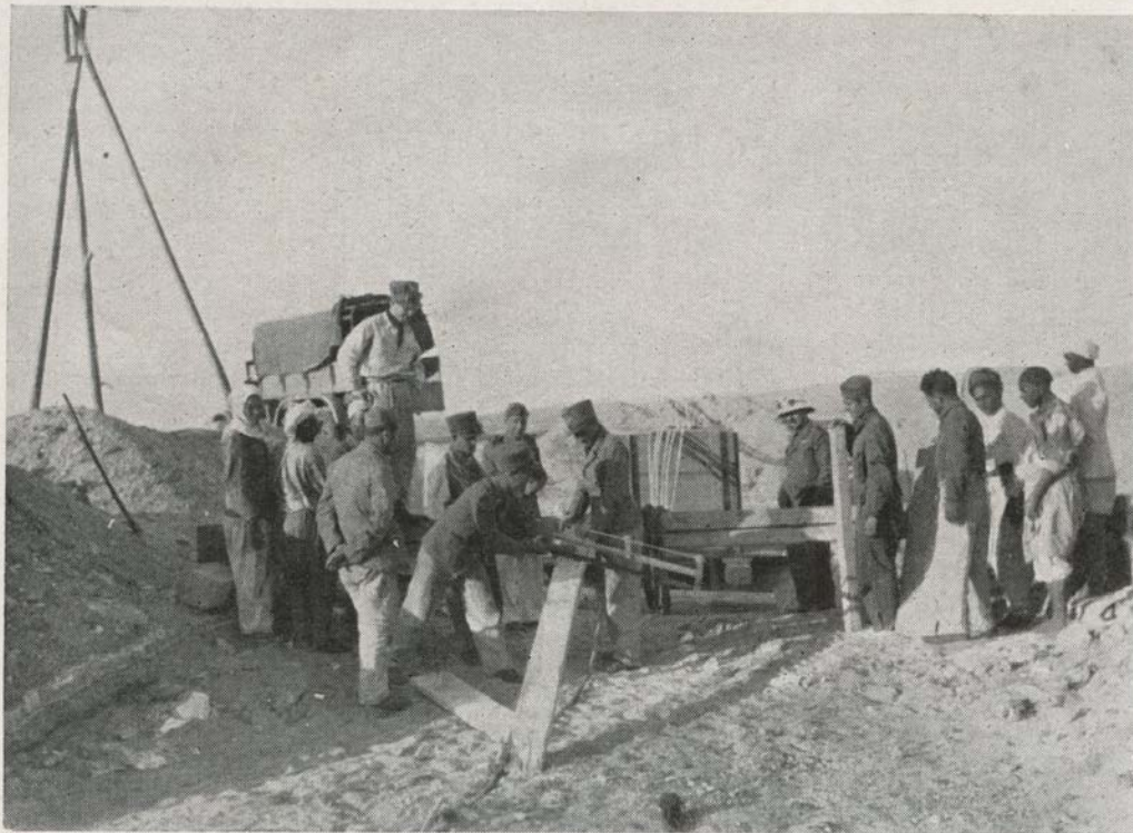
Si provvede alla costruzione di un castello per il sollevamento.
