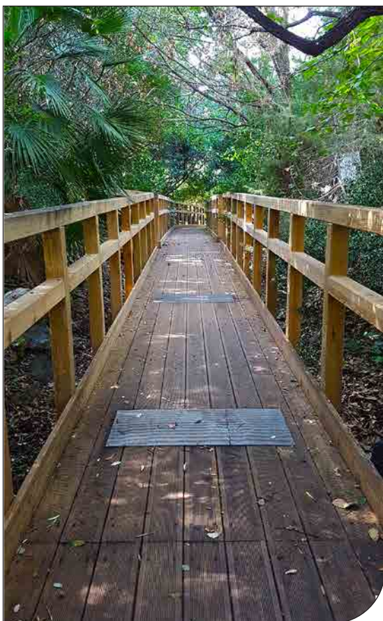
Fig. 8. Passerella in legno.
