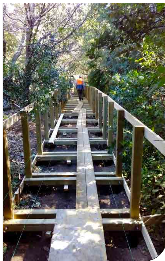
Fig. 7. Operazioni di adeguamento del preesistente percorso centrale dell'Orto Botanico per posizionamento passerella.
