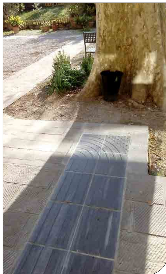
Fig. 3. Tratto di percorso in porfido per raccordo al percorso a guida naturale nel Parco Platani.
