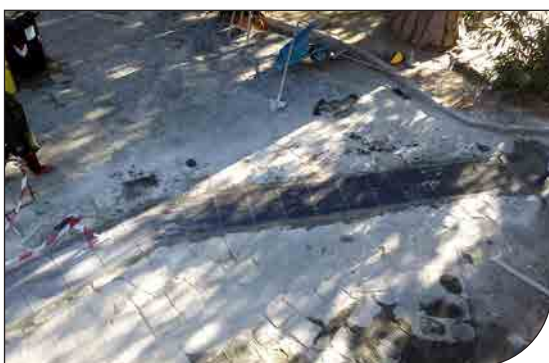
Fig. 1. Ingresso di Via Roma, sostituzione di pavimentazione a opus incertum per inserimento di pavimentazione tattile in porfido.
