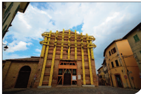
Fig. 1. Gabbia di sostegno alla sede del Museo delle Scienze
