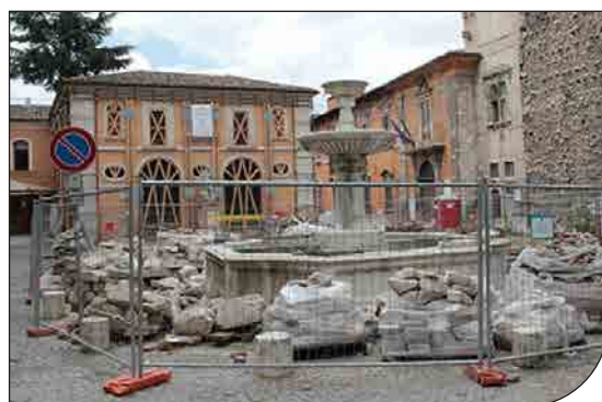
Fig. 4. Palazzo Camponeschi, a sinistra nella foto, nel post-sisma del 2009.
