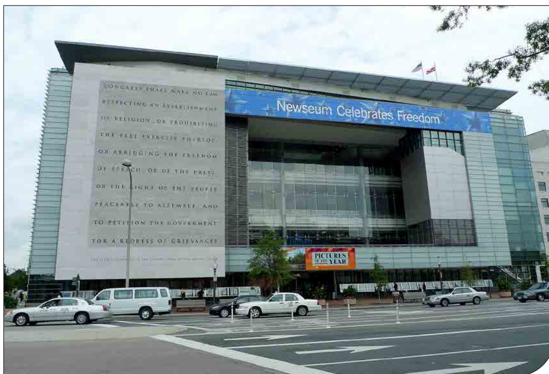
Fig. 1. Il palazzo del Newseum in Pennsylvania Avenue.
